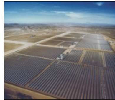
Abb. 2: Luftbild der solarthermischen Parabolrinnen-Kraftwerke bei Kramer Junction in der Mojave-Wüste in Kalifornien, USA
