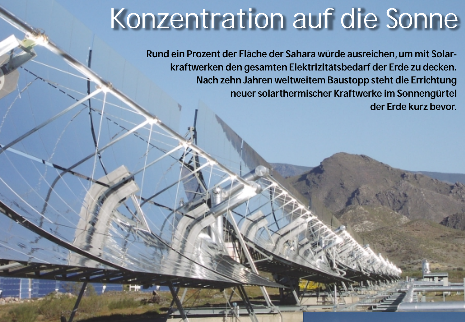
Abb. 1 a und b: Solarthermische Rinnenkollektoren einer Versuchsanlage am europäischen Testzentrum Plataforma Solar de Almería in Spanien
