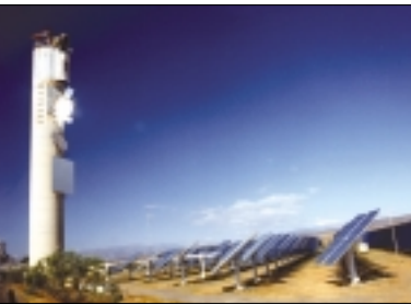
Abb. 3: Solarturm-Ver-suchs-Kraftwerk am euro-päischen Testzentrum Plataforma Solar de Alme-ria in Spanien
