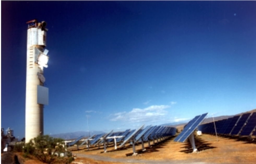
Bild 3: CESA-Solarturm-Versuchsanlage auf der Plataforma Solar de Almería
