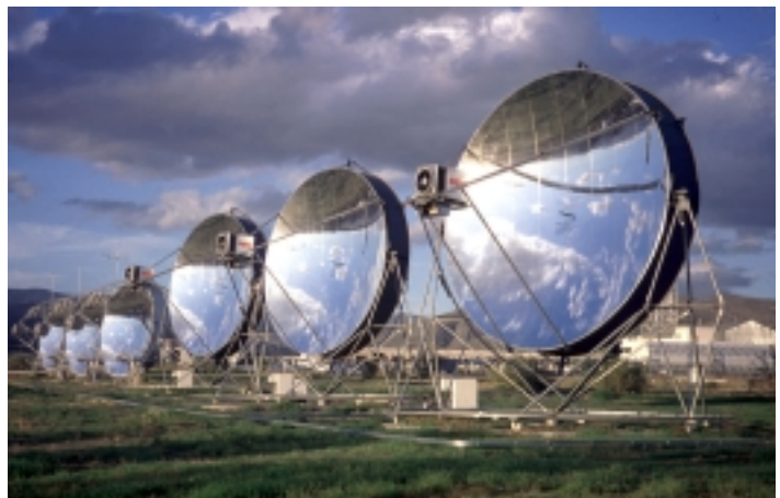
Bild 4: Dish/Stirling-Anlagen auf der Plataforma Solar de Almería mit Membran-Konzentrator (rechts) und Glasfaser-Struktur (links, in Vorbereitung)
